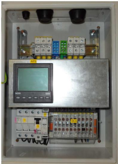
Rys. 2. Widok urządzenia STRAŻNIK MOCY UMOWNEJ PQ-SYSTEM firmy ELMONTAŻ Kraków [2]
